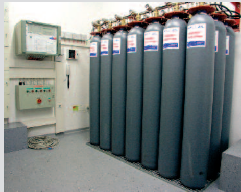
INERGEN-Löschanlage
