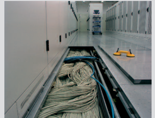
Doppelboden mit Leckgelokalisierung
