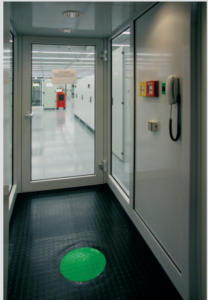
Vereinzelungszellen mit Sicherheitsabfrage und Gewichtssensor
